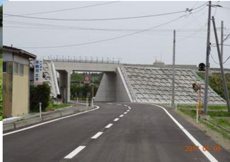
堂の内付近の完成した鉄道橋梁
