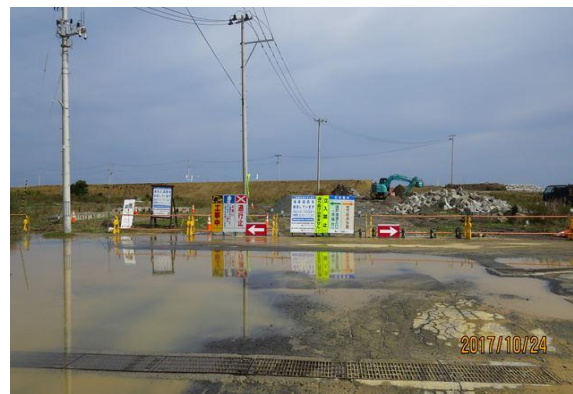
2017-10月 E地点 東 請戸外港への通行道路を通行止 として、海岸堤防復旧工事を開始
