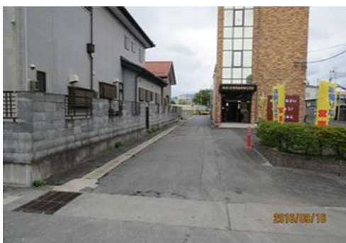
2016-9月 地点A 西 あぶくま信金営業再開 2017年4月、浪江町市街地を中心 に町民帰還が実現することに先立 ち金融機関の一つが再開された
