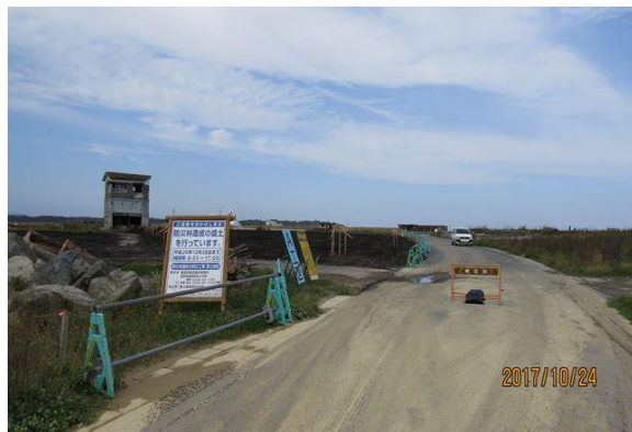
2017-10月 E地点 北 防災林工事と海岸堤防復旧工事 の対応で通行規制となる
