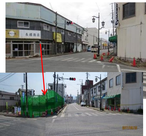
2017-5月 地点D 西 交差点の長橋商店他解体更地化された
