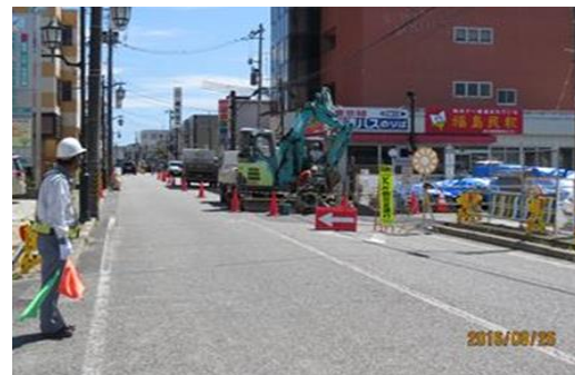
2016-8月 地点C 東 駅前通り復興へ道路側溝工事
