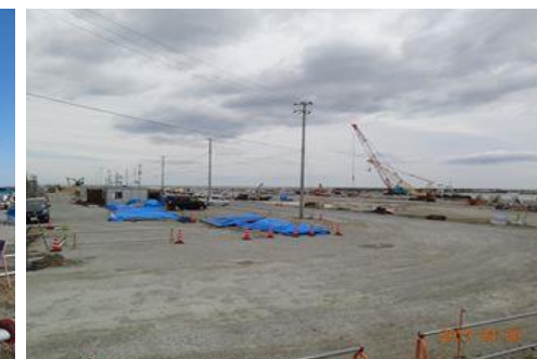
2017-4月 E地点 東北の請戸外港復旧工事
