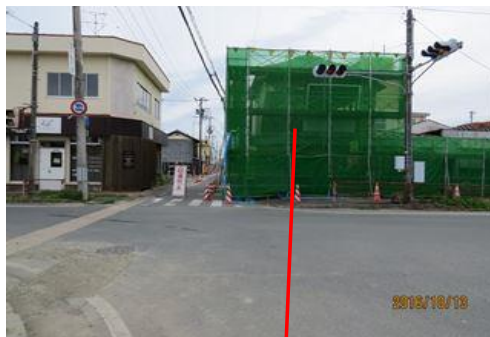
2016-10月 地点B 東 家屋倒壊の恐れあり、解体着手
