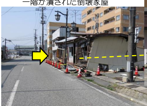
2014-10月 地点C 東 (C-D中間) 正面に浪江駅を望む新町通りの一階が潰された倒壊家屋
