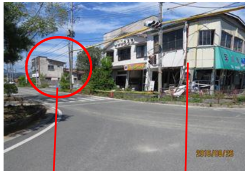
2016-9月 地点B 西 駅前交差点付近損壊店舗群の 解体完了、全域が更地化された
