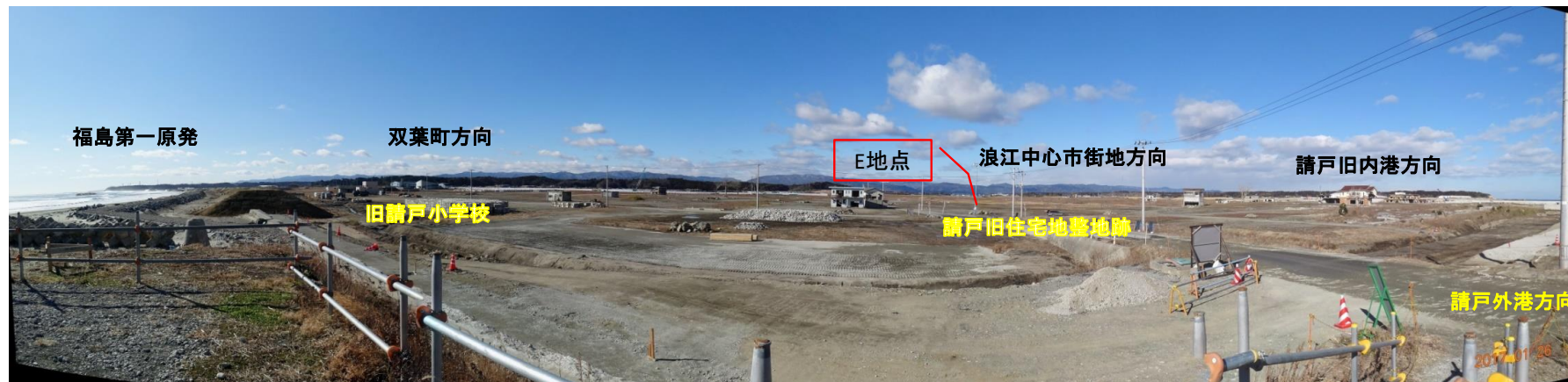
2017-3月 E地点 北(請戸内港付近) 請戸内港に残された廃墟建物群の解体が始まる
