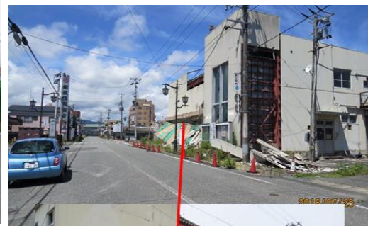
2016-10月 地点C 東(C-D中間) 駅前通り農協ストアの損壊荒廃が 目立ってきた
