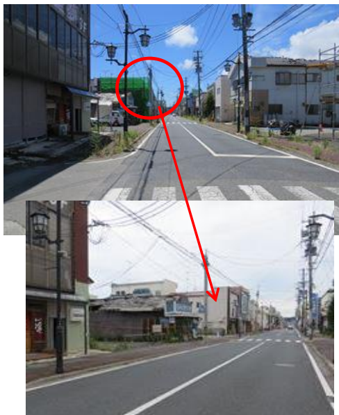
2016-7月 地点A 南 電気工事店解体工事完了、更地化された
