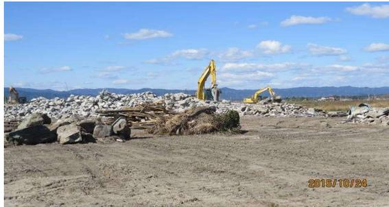
震災から5年有余、瓦礫が撤去され、流出家屋に残されたコンクリート土台部が、この期間に全て撤去され更地化されました
