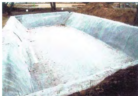
埋設部の遮水シート
