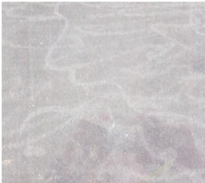
高圧洗浄機による洗浄跡。一筆書き状に洗浄。
