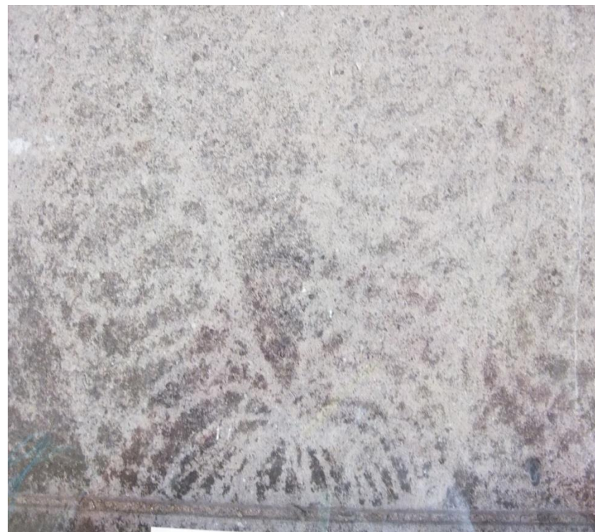
回転式ブラシによる洗浄跡。洗浄残しがみられる。
