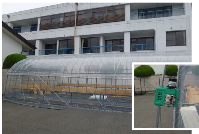
6/11 自動側面巻き上げ換気装置設置
