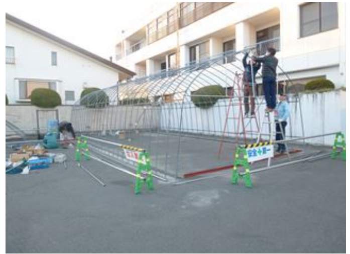
出入口取り付け工事
