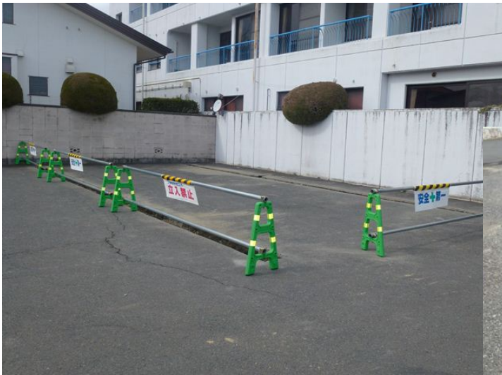
ハウス筐体埋め込み溝の掘削 協力:石川建設工業株式会社
