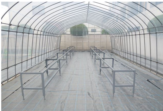
4/18 床シート張りと栽培ライン架台搬入
