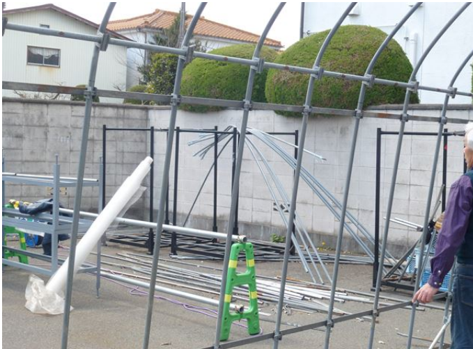
ネット張り段取り作業スタート
